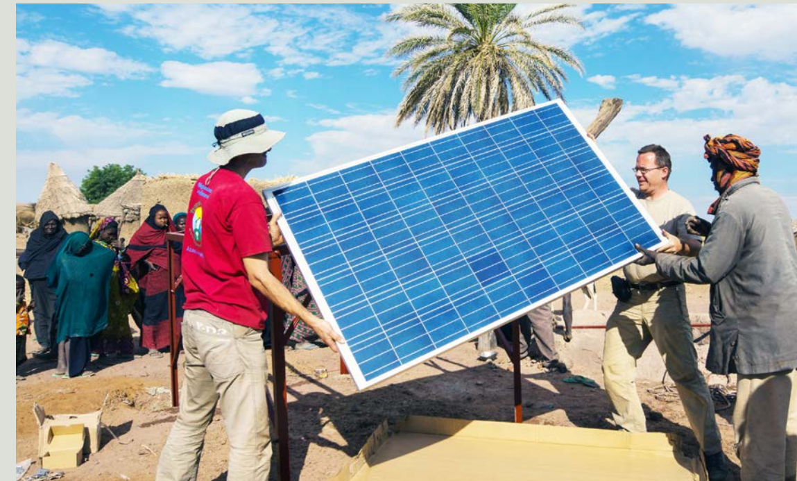
Solpaneler installeras i Mali. Foto: Budapest Bamako.
