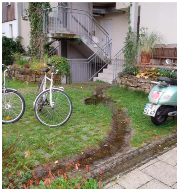
Hårdgjord dagvattenränna för avvattning av väg samt bräddning för takavrinning. Fördröjning och avledning av takavrinning inom fastighetsgräns i Freiburg, Tyskland (Foto: Ramböll).
