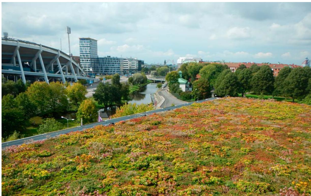
Sedumtak i Göteborg (Foto: VegTech)
