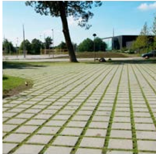
Beläggning med genomsläppliga fogar, Siena 10 cm
