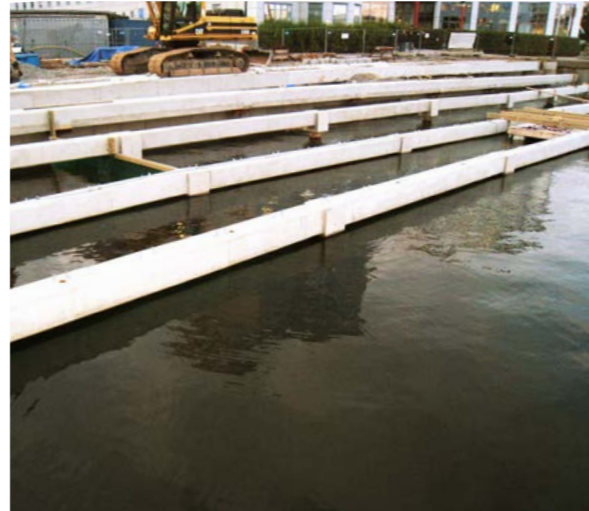
Skärmdamm under konstruktion, Marevik, Stockholm. Foto: Ramböll
