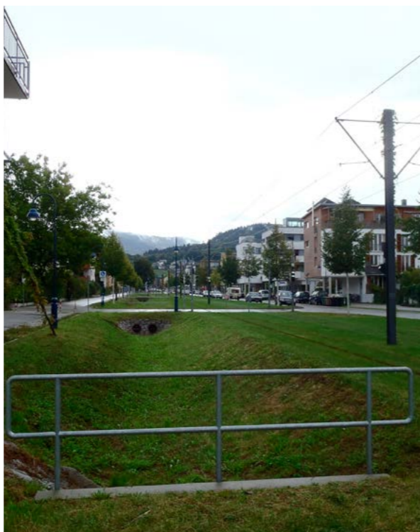
Större dike bredvid spårvagnsrälsens används som huvudstråk för dagvatten från området och för att dränera rälsens överbyggnad (Foto: Ramböll).
