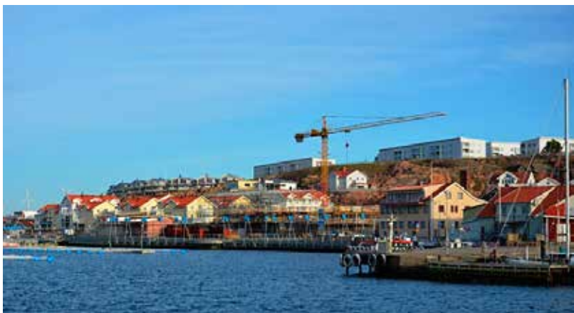
Ägarlägenheter under byggnation i ett kustnära läge i Lysekil. Foto: Svante Dolff
